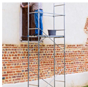
Un échafaudage roulant pour une variété de tâches
