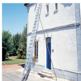
Verwendung mit Fassadenabstützung
