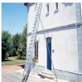
Utilizzo in appoggio contro la facciata
