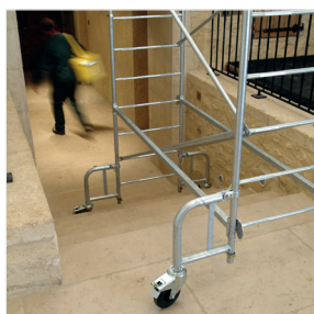
Montagem em desnível
